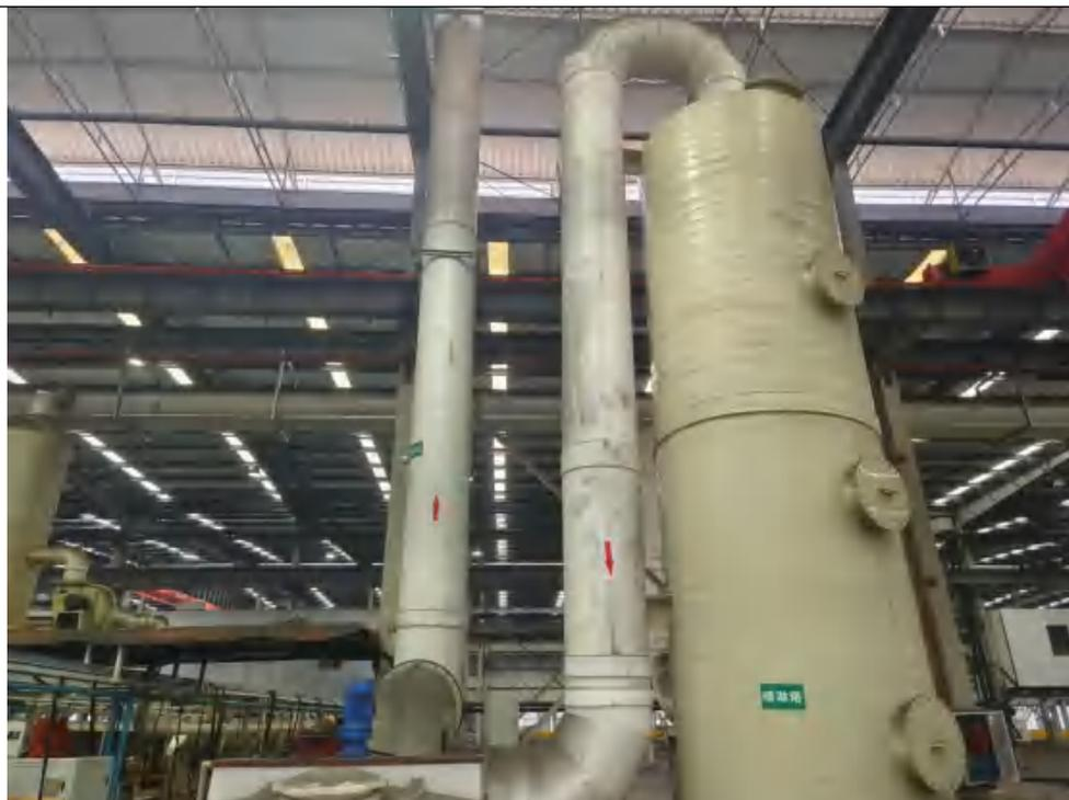
化镀生产线硫酸雾废气处理设施图
