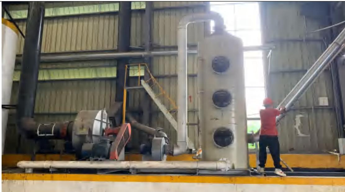
配粉工序配粉、搅拌粉尘喷淋塔废气处理设施
