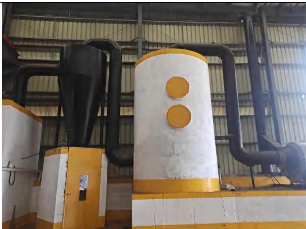
配粉粉尘旋风布袋除尘+喷淋塔废气处理设施图
