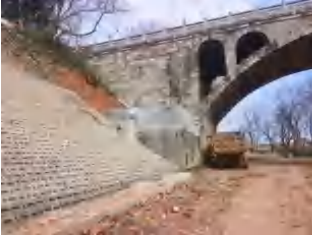
涿水大桥1桥面雨水径流收集系统及缓冲事故池
