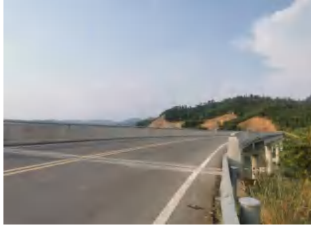
道路及桥梁围挡
