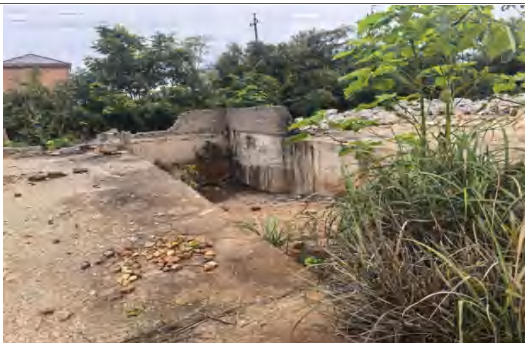
地块现状（厂区沉淀池）
