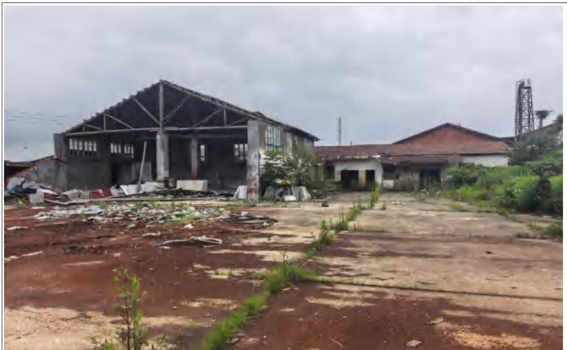
地块部分未拆除的厂房
